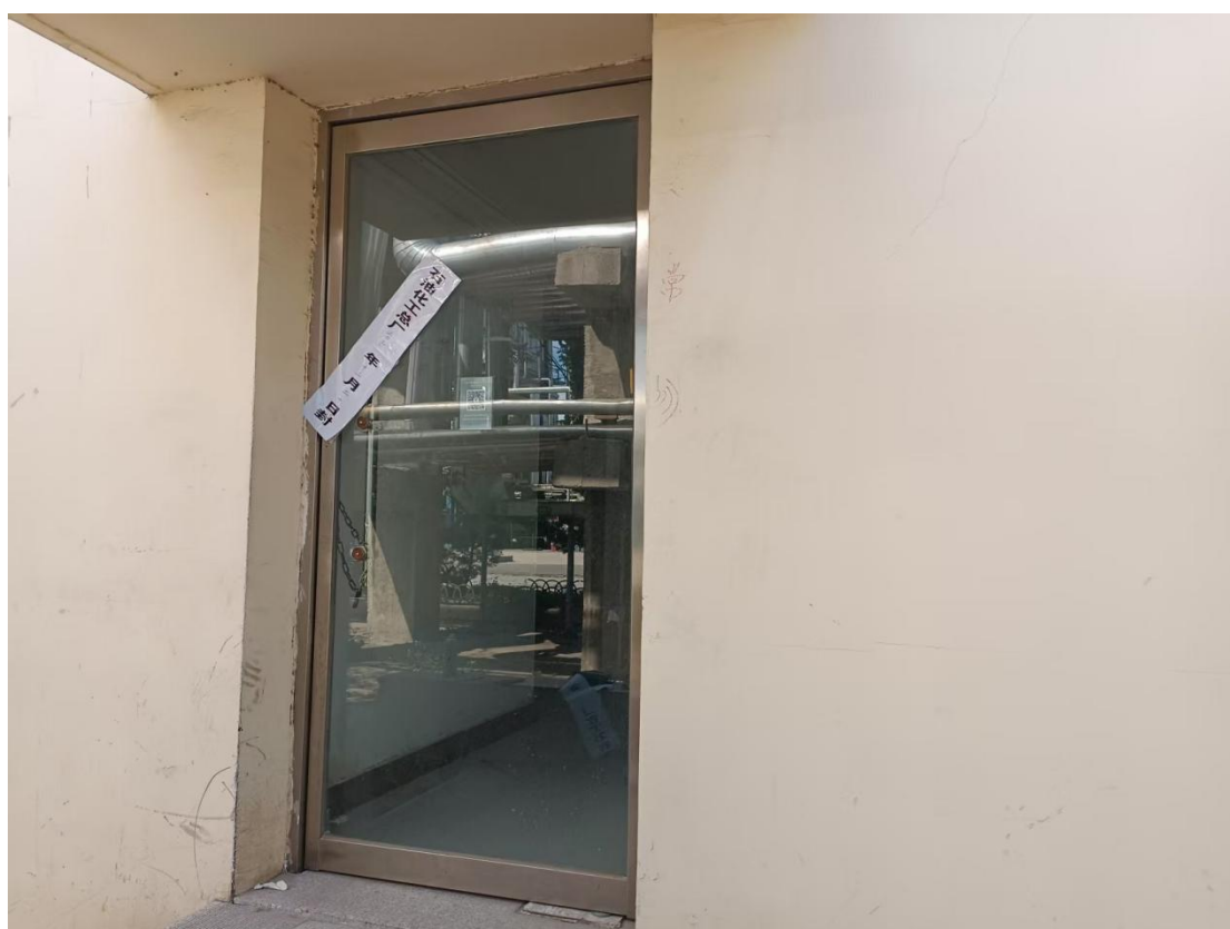
(3) 柴油凝点在线分析小屋：室内仪器已拆除，现已停用闲置，封闭贴封条，现场照片：
