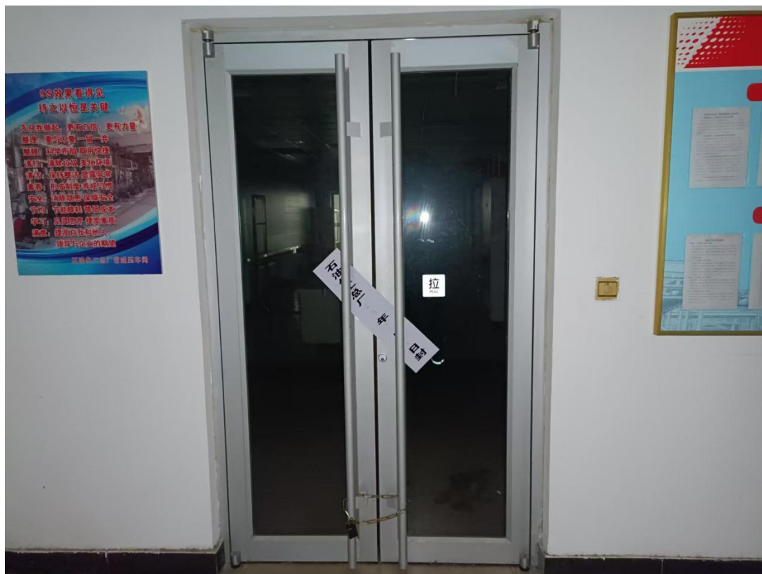
(2) 操作室：现已停用闲置，封闭贴封条。现场照片：
