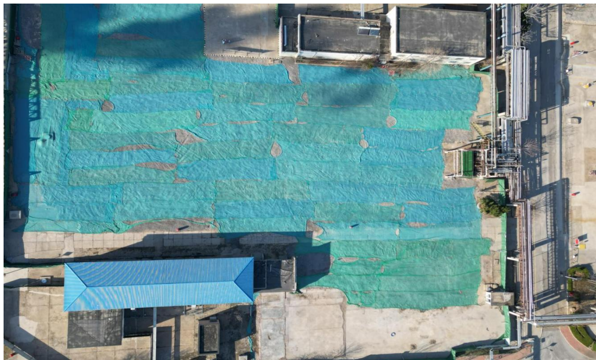
图 2.2-2 220 万吨/年常减压蒸馏装置拆除后现场照片
